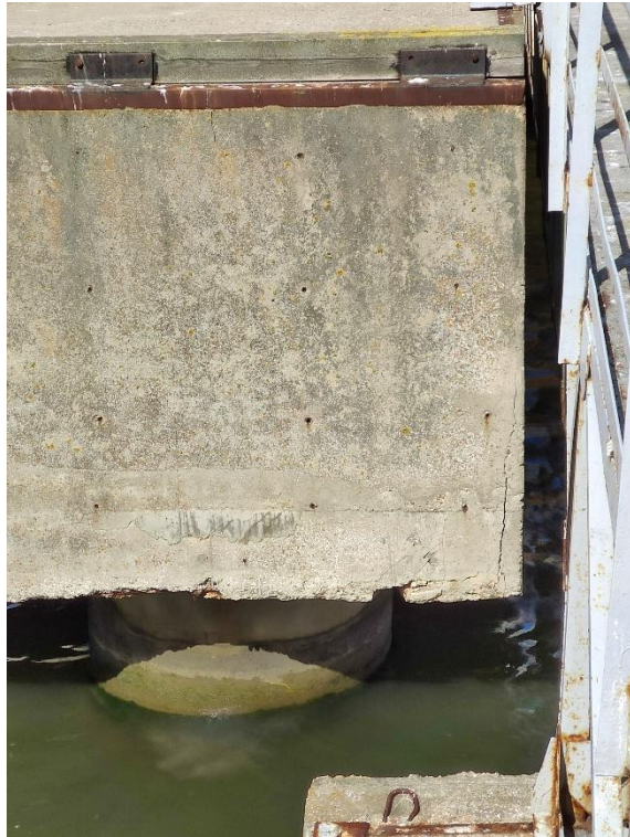
Att. 7 – Atdurpāļa Nr.3 un dienesta tiltiņa deformācijas
