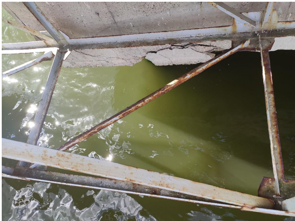
Att. 8 – Atdurpāļa Nr.3 deformācijas betonā tērauda pāļu tiešā tuvumā
