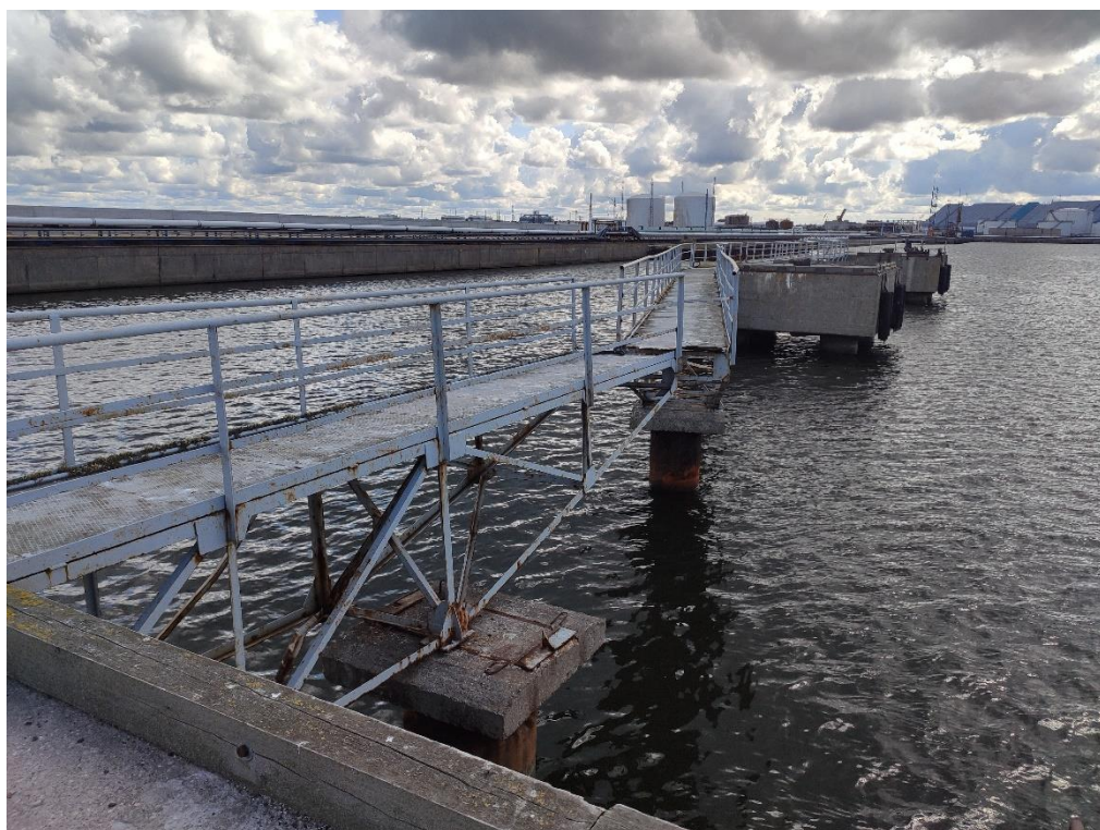
Att. 10 – Dienesta tiltiņa balsta konstrukcija
